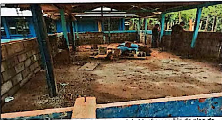
Foto 5: Proceso de rehabilitación de pared de block y cambio de piso de esta aula
