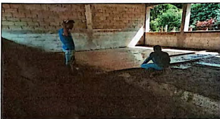
Foto 3: Proceso de cambio de piso
