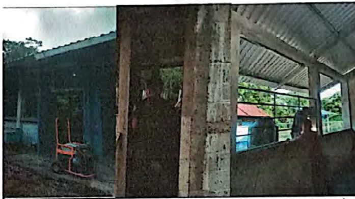
Foto 4: Proceso de sustitución de 2 puertas de madera por dos de metal y cambio de ventana de madera por ventada de metal con vidrio.
