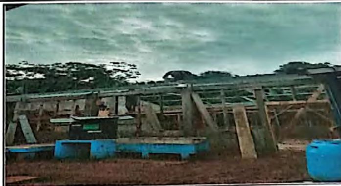
Foto 2: Proceso de cambio de estructura de techo y cubierta de lamina
